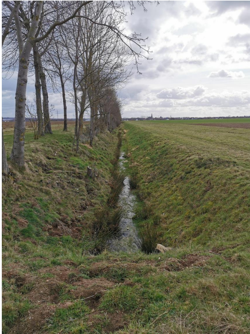
A - VII: Entwässerungsgraben ca. 13,5 m (Grünstreifen) hinter der nördlichen Plangebietsgrenze (Nordwesteck Richtung Nordosteck)
