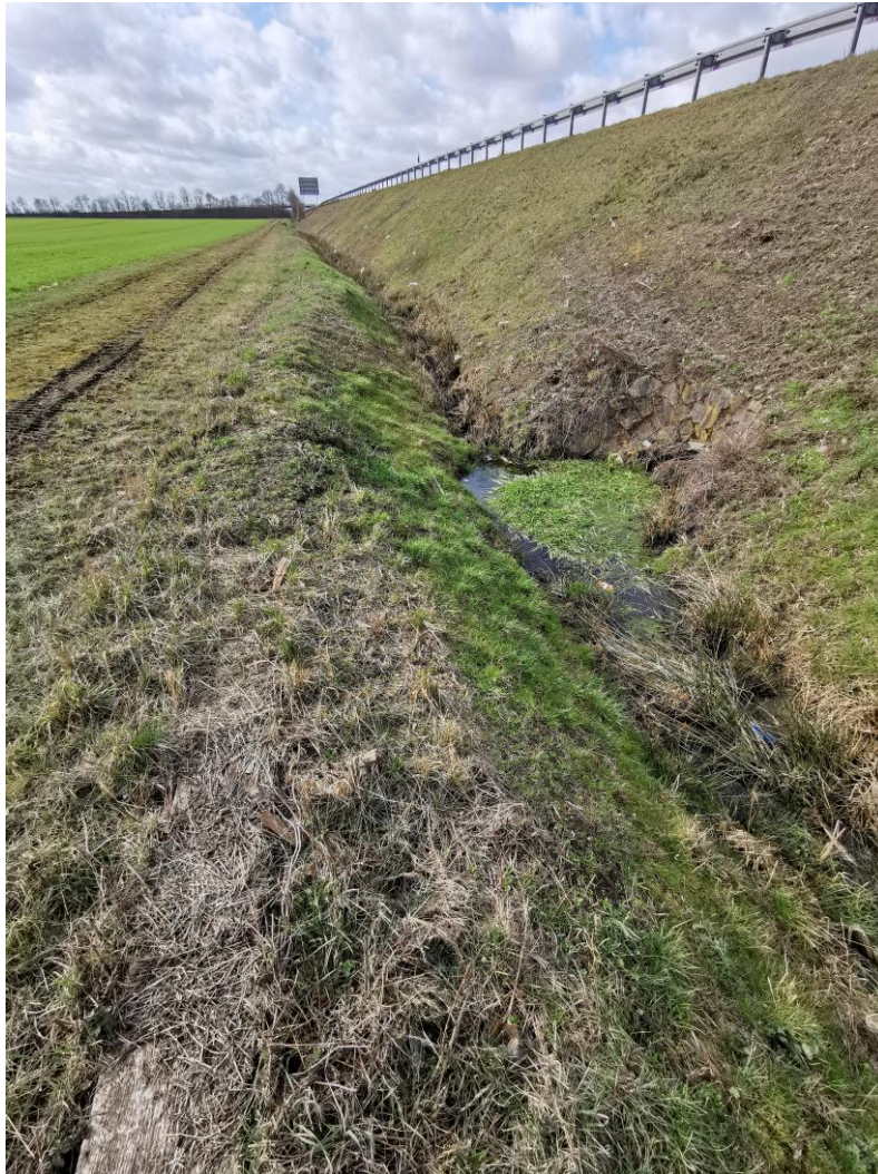
A - X: Blick entlang des Entwässerungsgrabens ca. 6 m (Grünstreifen) hinter der westlichen Plangebietsgrenze (Nordwesteck Richtung Südwesteck) mit Blick entlang der die A1
